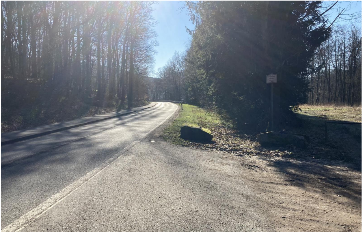
Abbildung 3: Adolf-Koch-Straße, Blick aus der bestehenden Haltebucht Richtung Süden (Bildquelle: SCHWEIGER + SCHOLZ Ingenieurpartnerschaft mbB, Februar 2023)
